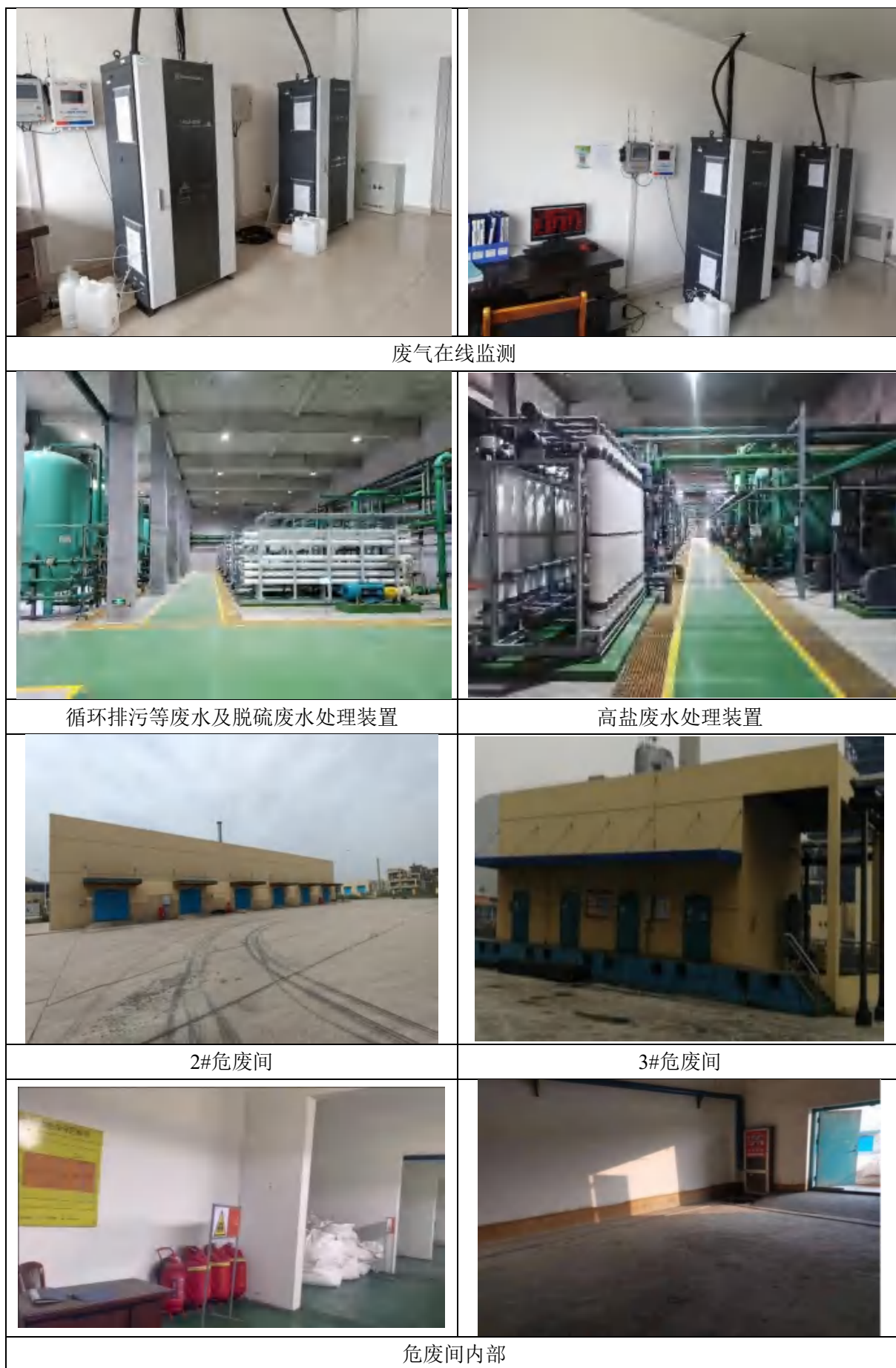
图 3.2-1 现有工程现场图
