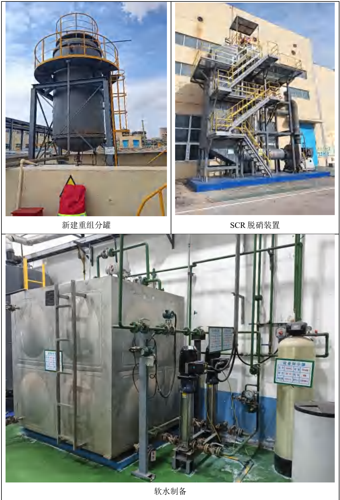
图 4.4-1 本项目建设现状
